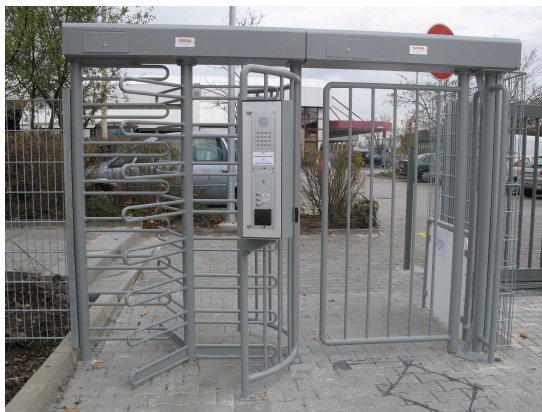
Bild 4: Weitere Variante einer Kombination von einer Personen- und gleichzeitiger Fahrradsperrre. Die Fahrradsperrre kann bei Bedarf auch als Durchgang für sperriges Gut verwendet werden. Die Peripherie besteht aus Zugangskontrolle und Gegensprechanlage
