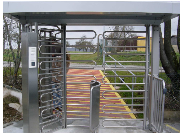
Bild 6: Drehkreuz in Spezialausführung. Hier werden einmal die Personen, die das Drehkreuz passieren wollen in Verbindung mit einer Zugangskontrolle vereinzelt. Daneben befindet sich ein motorisch gesteuertes Tor für den Transport von Waren. Dieses Tor kann nur von den Mitarbeitern, die dazu berechtigt sind, geöffnet werden.
