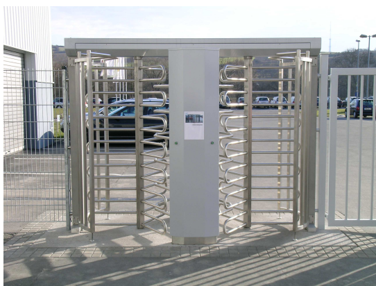
Bild 5: Doppeldrehkreuz, wird verwendet, wenn eine große Zahl von Mitarbeitern durchgeschleust werden muss.
