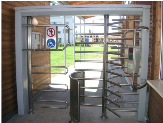
Bild 3: Sperrvorrichtung mit einem Drehkreuz für Fußgänger und einem integrierten Durchgang für Rollstuhlfahrer. Ausführung in Edelstahl.
