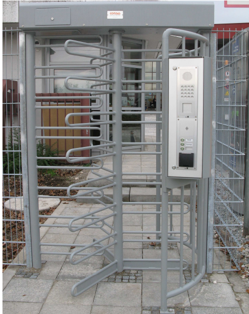
Bild 1: Drehkreuz mit 120° Teilung, mit Zugangskontrolle und Gegensprechanlage
